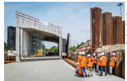
Mit Hydraulikkraft wird hier das Teil für die S-Bahn verschoben.
