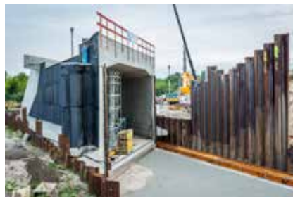
Der Verschub auf Seite der S-Bahn – so wird es auch bei der Fernbahn aussehen.
