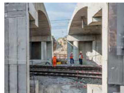
Blick auf die Baustelle kurz vor dem Lückenschluss. Foto: Mathias Richter/Contempo
