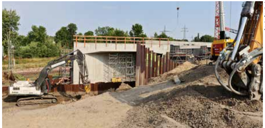
Blick auf die Verbindungskurve nach dem Abriss. Hier schon zu sehen: Kreuzungsbauwerke sind Brücken, über und unter denen Züge fahren.
